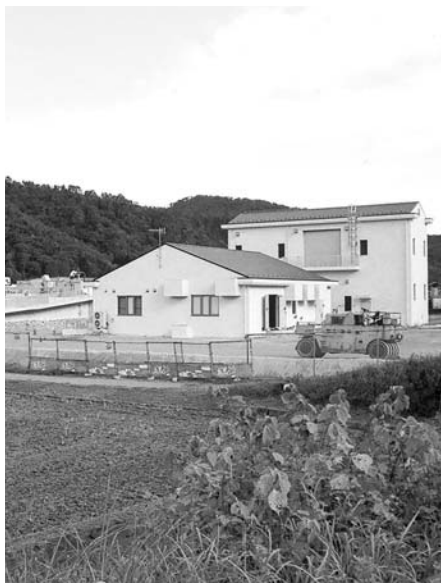
現在建設中の下水処理場（八千代町）
