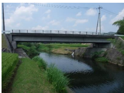
美土里橋 L = 30.0 m (PC橋) 1978年 架設
