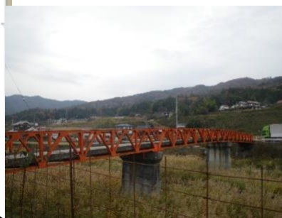
鹿洲橋 L = 51.5 m (鋼橋) 1971年 架設
