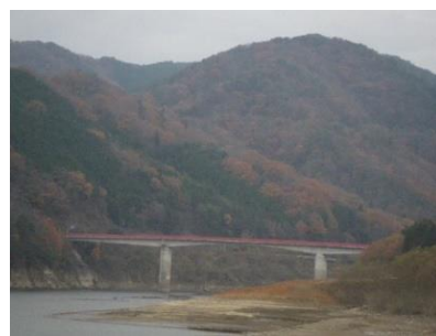
土師大橋 L = 189.1 m (PC橋) 1972年 架設
