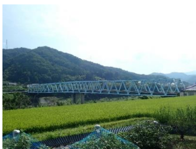
香淀大橋 L = 204.2 m (鋼橋) 1985年 架設
