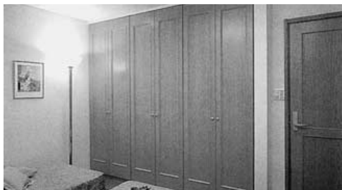
地域木材を活用した合板建築（内装材）
