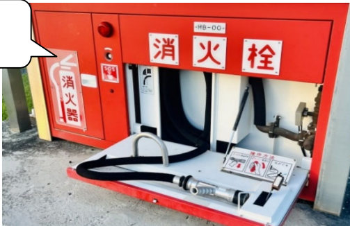
トンネル工区②
