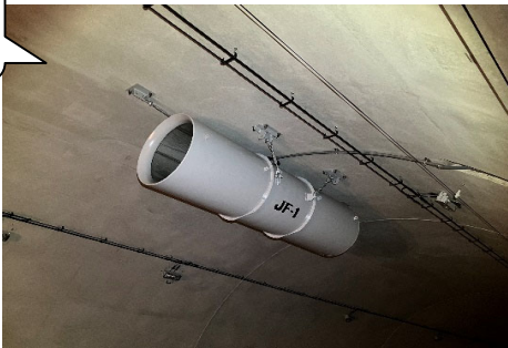
トンネル工区③
