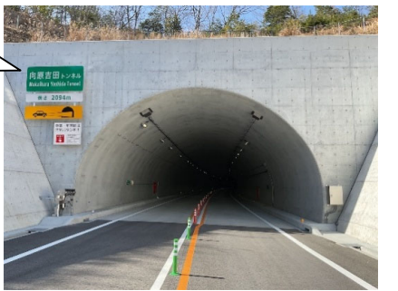
トンネル工区④
