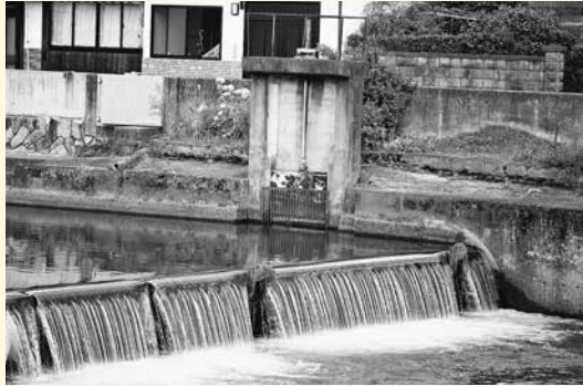
お茶屋頭首工(可動堰と取水口)
