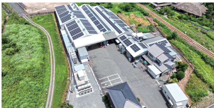
■太陽光発電パネル設置
