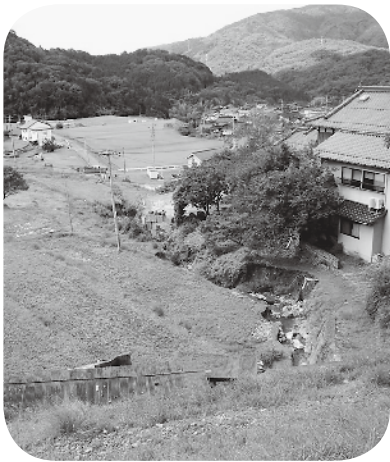
8/20 豪雨 八千代町上根 普通河川 土井川災害箇所
