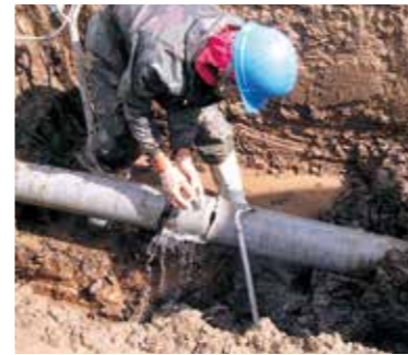
漏水工事の様子
