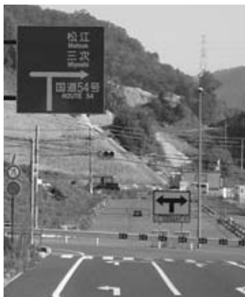
工事が進む可部バイパス
