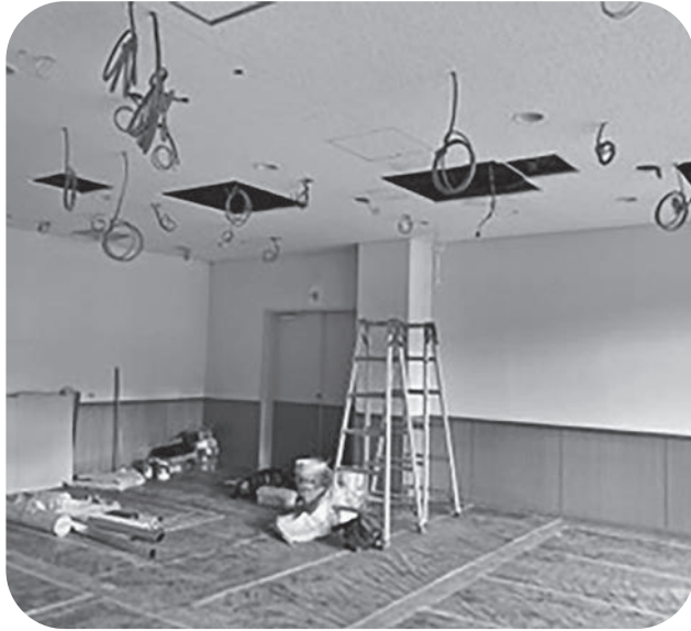
JA吉田総合病院 施設の一部を「発熱外来」へ改修
