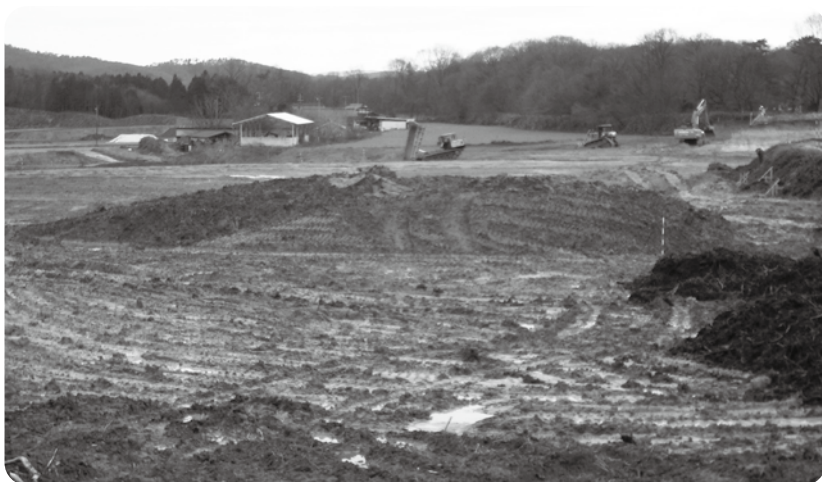
造成中の原山地区大規模農業団地
