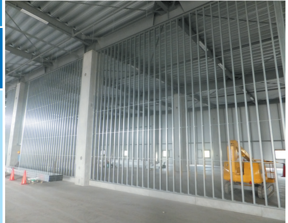
■千葉県流山市大型物流倉庫新築工事
