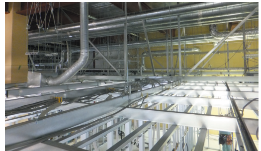
■山口県周南市工場新築工事①
