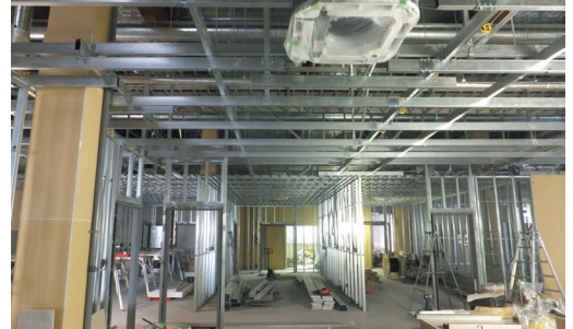
■山口県周南市工場新築工事②
