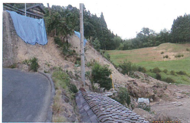
中馬地区 説教所跡地のがけ崩れ現場
