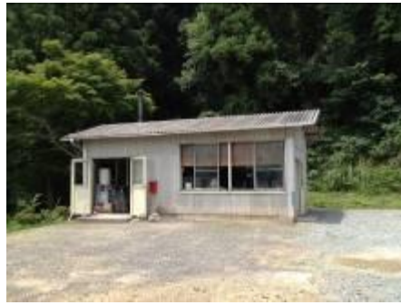
公園の角地に鉄骨スレート造りの建物内で、作業室・陶芸窯が完備している
