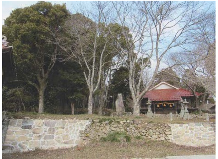
石垣の補修状況
