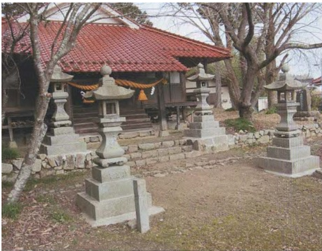
石燈籠の補修状況
