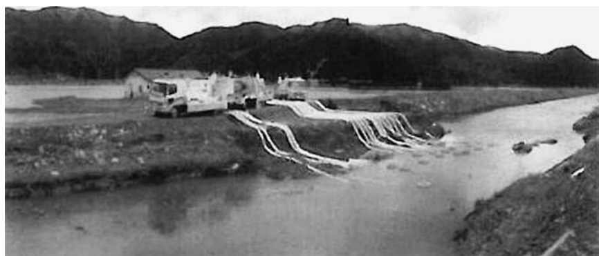
排水作業状況（石巻市釜石地区）
