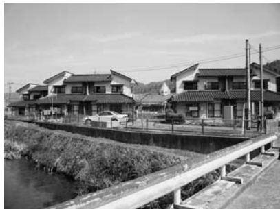
北生住宅(美土里町生田)
