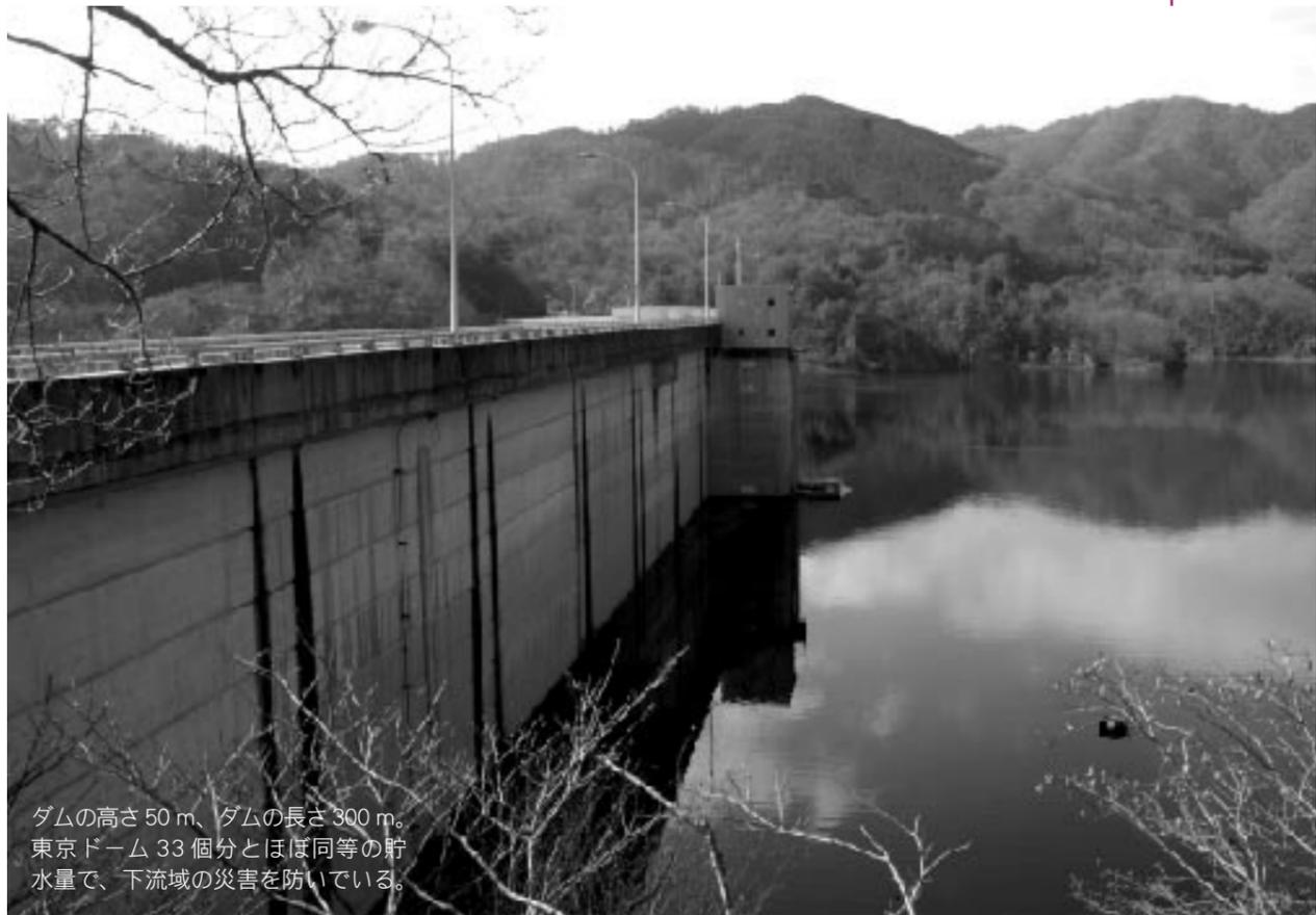
ダムの高さ50m、ダムの長さ300m。東京ドーム33個分とほぼ同等の貯水量で、下流域の災害を防いでいる。
