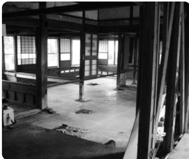
改築中の民家
