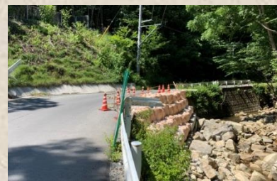
大型土のうによる仮復旧により通行可能に
