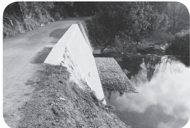
災害復旧場所の一部(美土里町生田)
