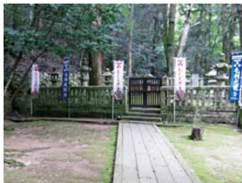
玉垣，門扉の修繕
