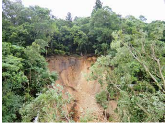
郡山公園東側斜面大規模崩壊 (平成22年)
