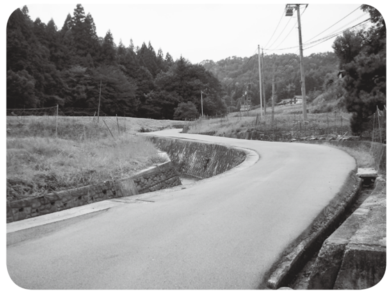
危険なカーブ箇所
