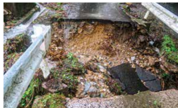
市道下土師線(八千代町土師)
