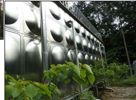
長迫配水池 (H17)
