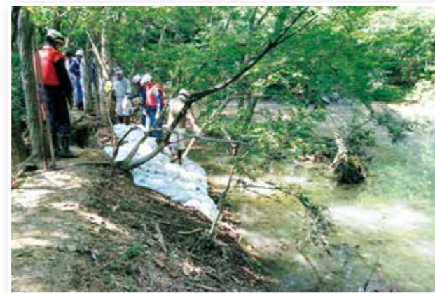
応急的に補強したため池
