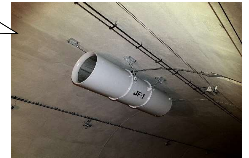
トンネル工区③
