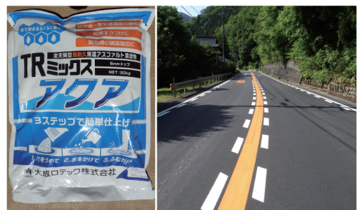
■高耐久常温合材 アクア ■舗装現場
