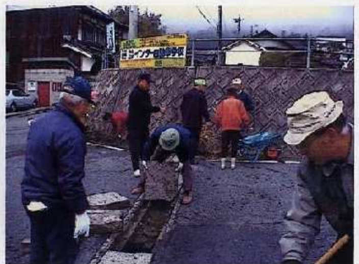
駅前道路側溝の清掃
