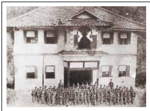
↑ 高田原尋常小学校 (明治29年9月9日)
