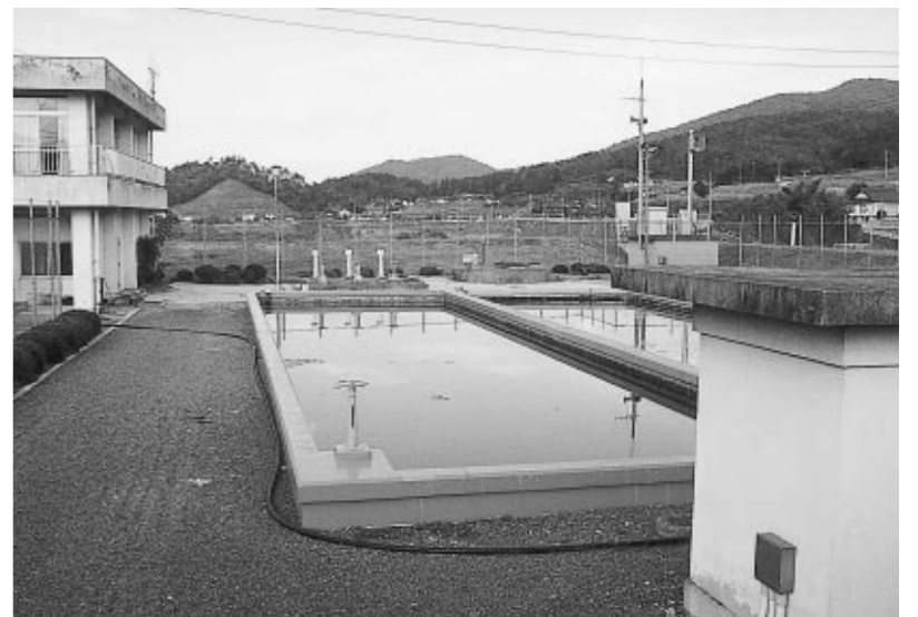
小原浄水場(甲田町)
