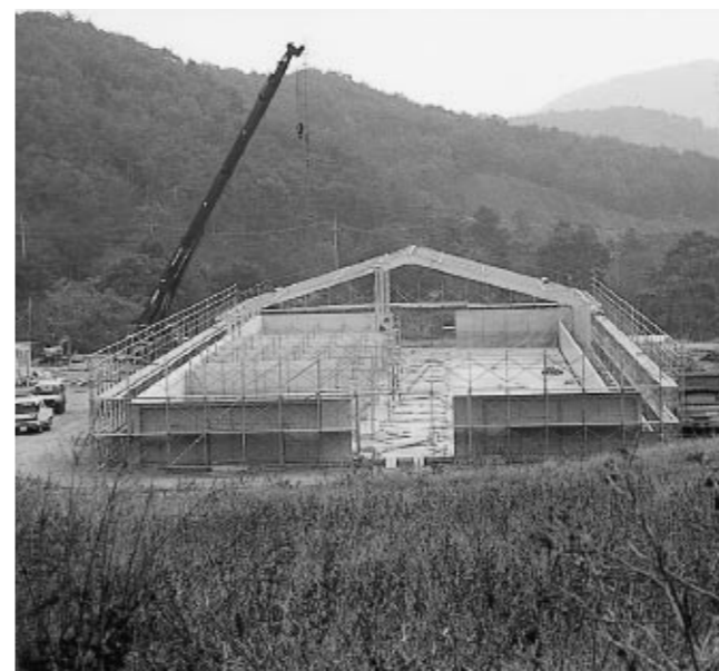
建設中の高宮堆肥センター(高宮町)
