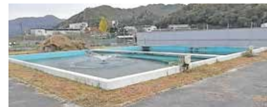
老朽化した上水道施設(緩速ろ過池)
