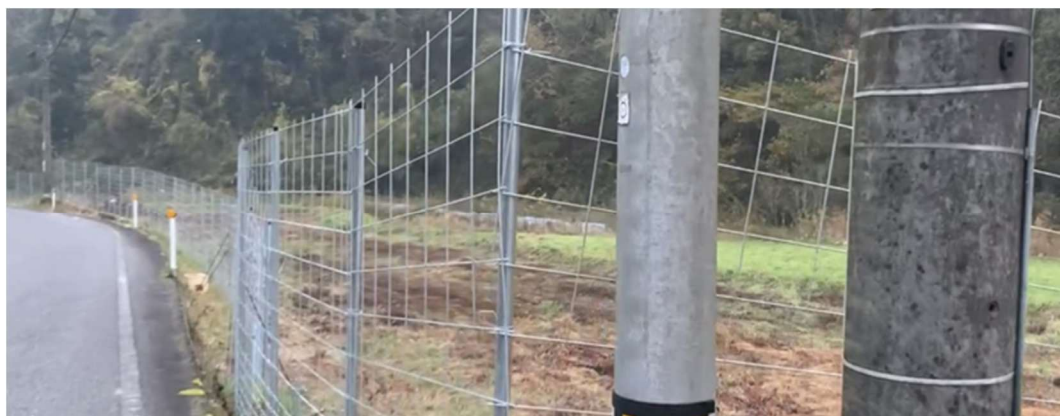
高宮町上式敷地区に設置された新たな防護柵（令和5年11月撮影）
