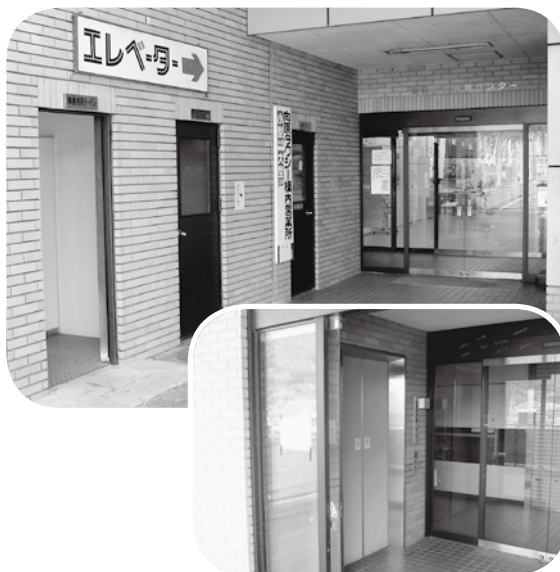
更新予定の向原駅エレベーター
