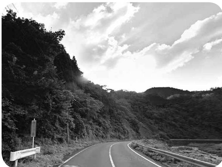
落石により死亡事故が起きた現場(島根県邑南町)
