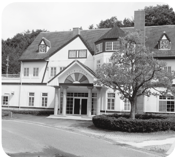
施設改修予定のジビエ加工処理施設（高宮町）
