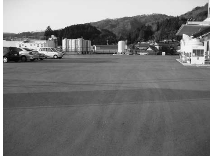
統合給食センターいよいよ着工へ (アグリフーズ駐車場敷地)
