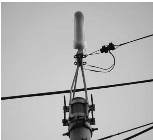
防犯灯のLED化工事など実施
