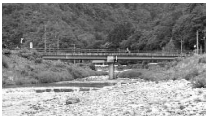
▲⑦川根まるごとエコミュージアム 川根地域は田舎の風景を守ろうと取り組みを進めている。そのため川や道路の工事、人や生物にやさしい整備になっている。
