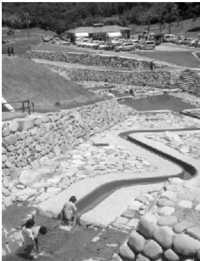
▲⑥高宮町茂谷砂防公園 つい先日完成した公園。水の滑り台「ウォータースライダー」が作られている。その他、地域で整備されたハイキングコースもある。
