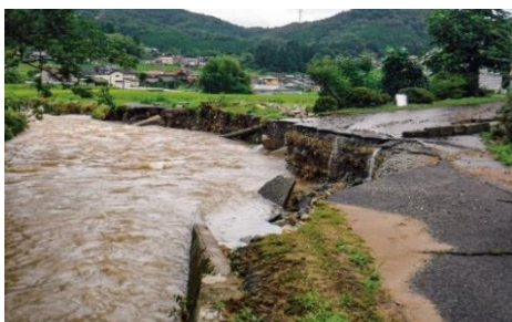
市道中原線（美土里町）
