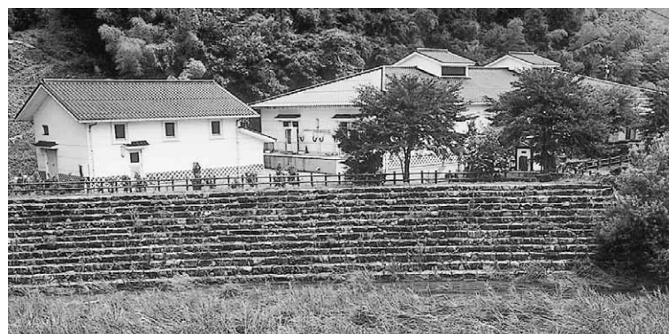
環境良好 (向原中央浄化センター)
