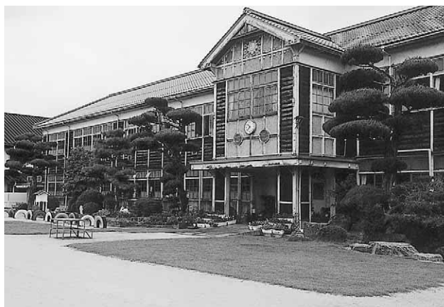
市内最古の校舎（昭和10年建設）郷野小学校
