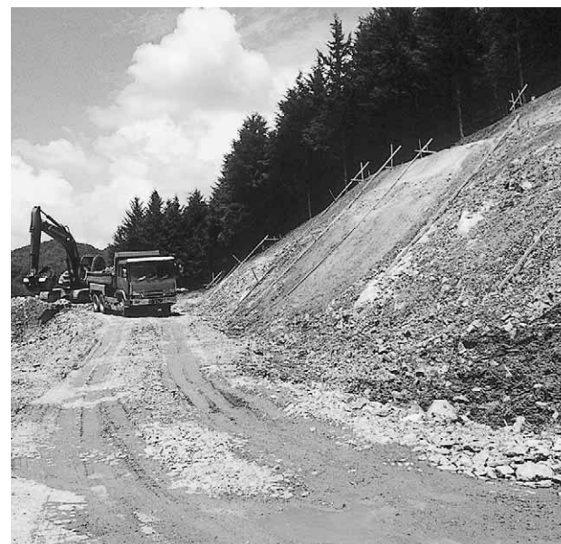
県道原田・吉田線の工事現場
