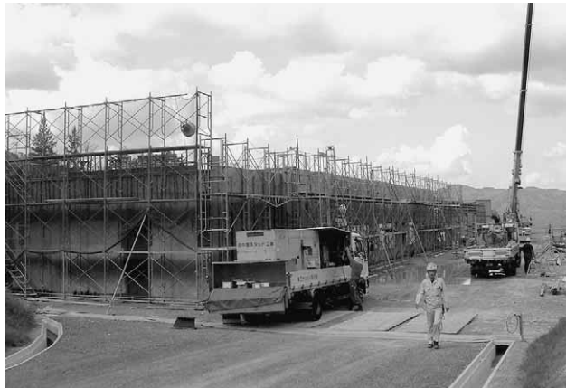
温水プール建設現場(進捗よく率40%、8月現在)
