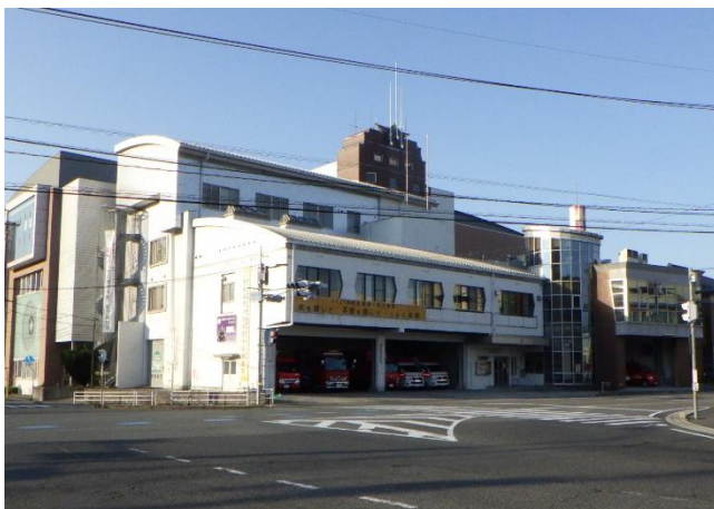
安芸高田市消防本部 安芸高田消防署 本署
