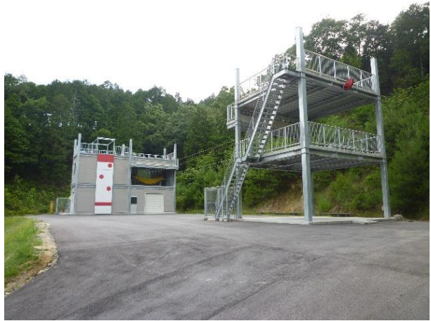
安芸高田市消防本部訓練場 (西浦訓練場)
