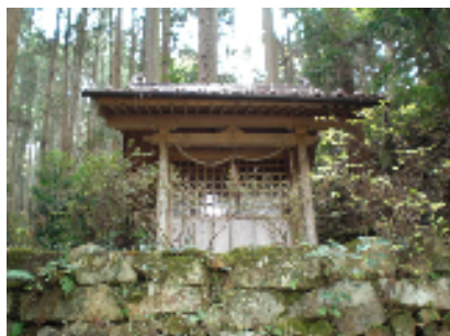
5区(長谷尻)内藤宅付近
