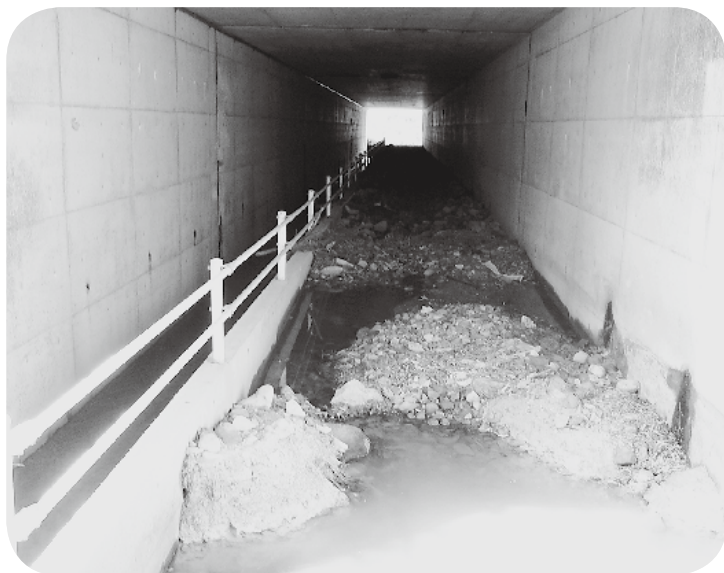
高速道路下の排水路
