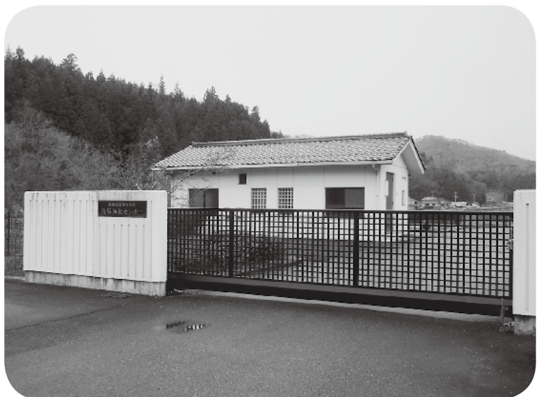
台帳整備される農業集落排水施設
