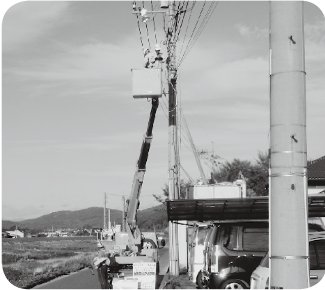
光ファイバー敷設工事
