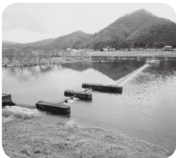
土師ダム下流・入江床止 (河床下に既存埋設管)
