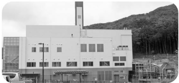
高効率原燃料回収施設(南但クリーンセンター)
