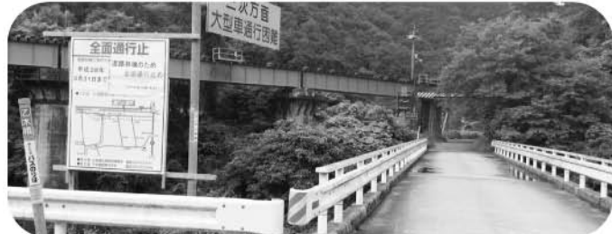
県道の通行止を示す工事看板
